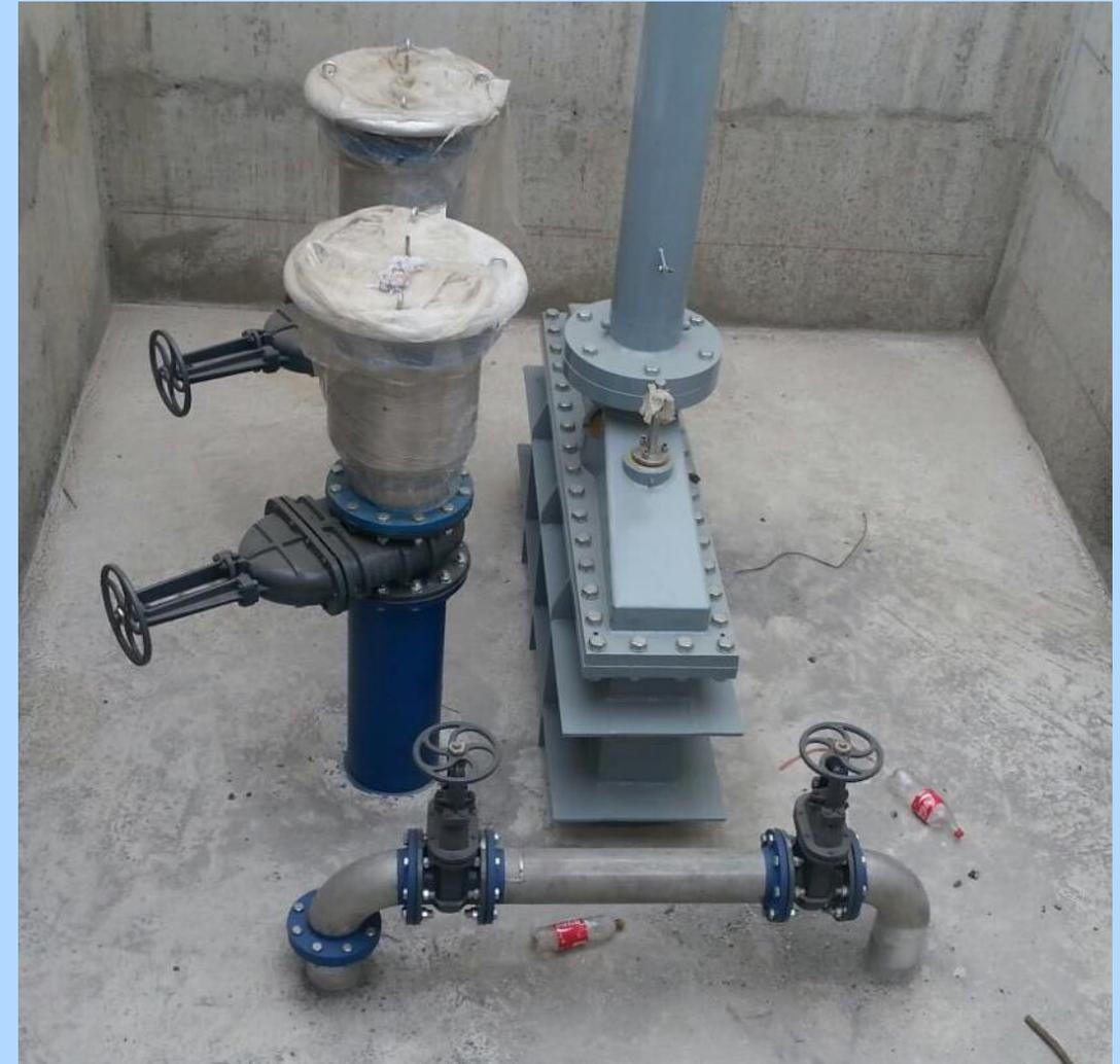
Compuerta con aducciones y by-pass. Fuente: Inhisa Hidráulica S.A.
